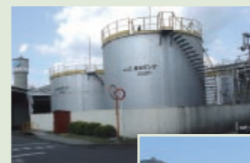
重油タンク撤去前
